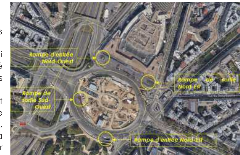
Figure 65 : Implantation des rampes du parc de stationnement sur la Place Maillot – source : DVD, 2019
