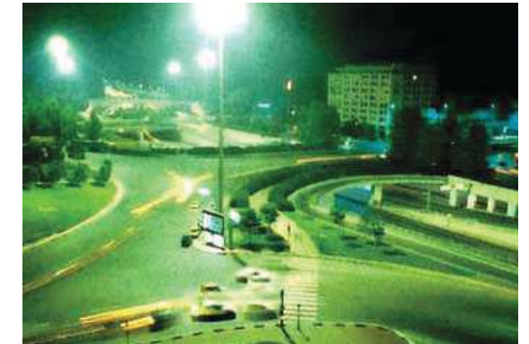
Figure 48 : Mâts d'éclairage de type routier de grande hauteur de la Porte Maillot - Porte Maillot, 1980
