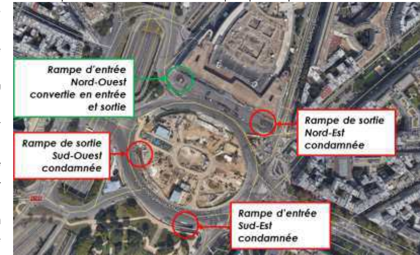
Figure 29 : Condamnations et mutations des rampes d'accès du parc de stationnement du Palais des Congrès – source : DVD, 2019
