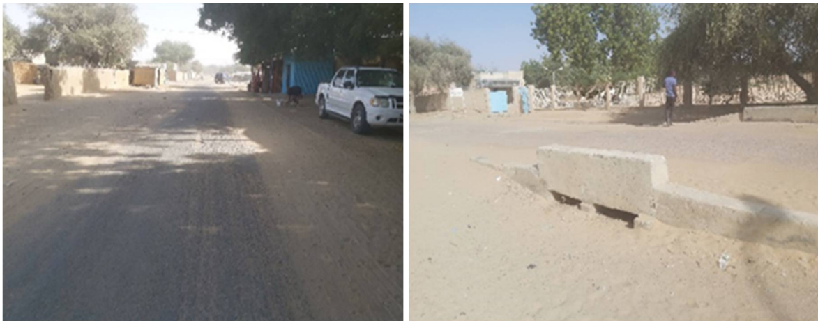
Photo 7: Etat de la voirie revêtue
