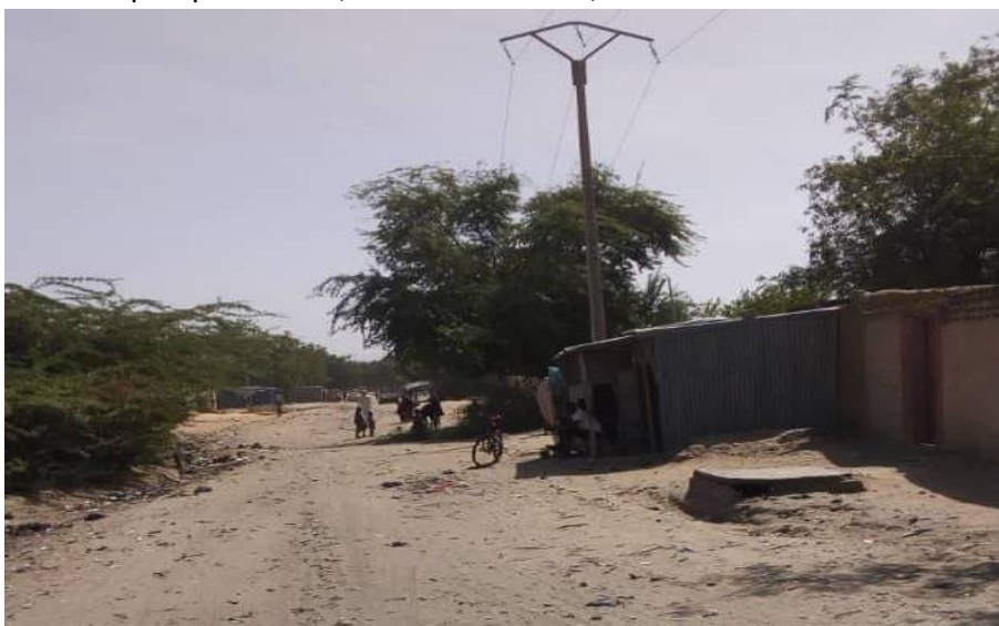
Photo 6: Installation commerciale (Kiosque) sur l'emprise des travaux
