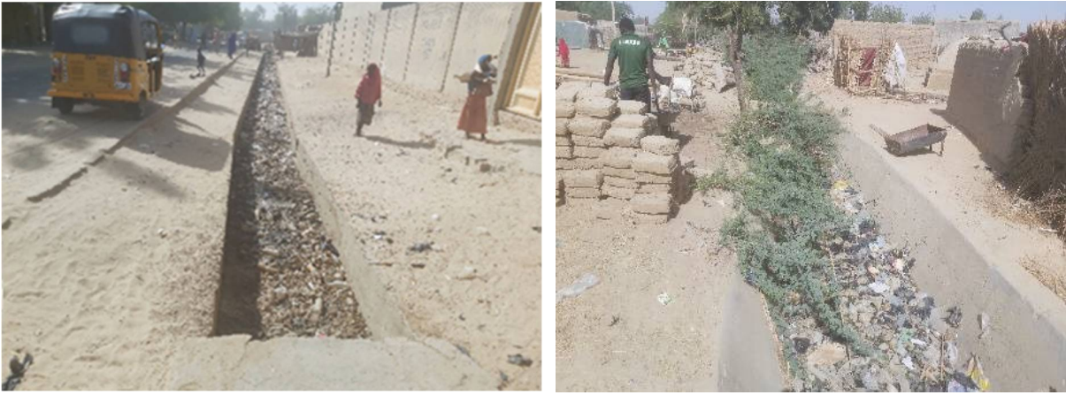
Photo 9: Etat des caniveaux existants
