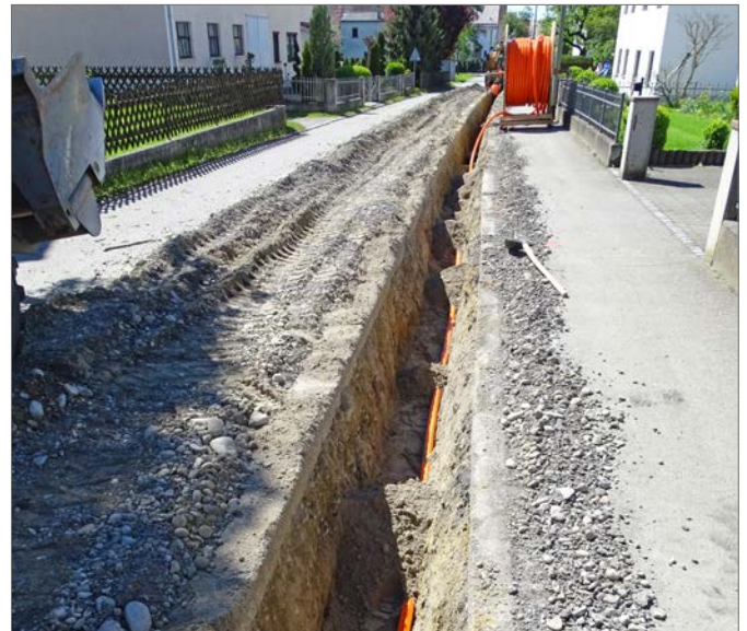
Verlegung RAUSPEED 24 x 10 x 2,0
