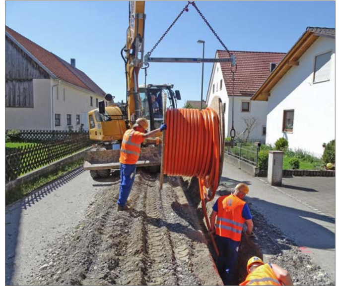
Verlegung RAUSPEED 24 x 10 x 2,0
