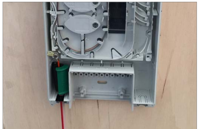
Ansicht Hausanschlussbox (AP)
