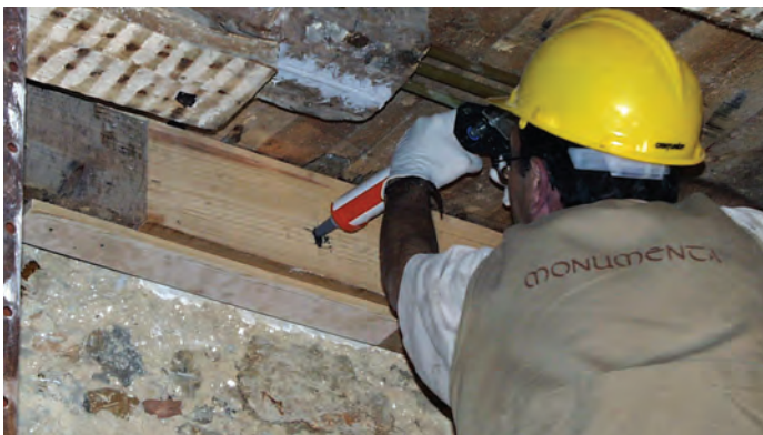
Injecção de calda epoxídica TG6 Timber Grout nas próteses
