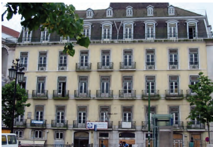
O edifício antes do início das obras
