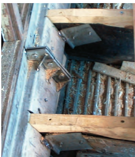
Pormenor do anel em aço inox de fecho da Cúpula
