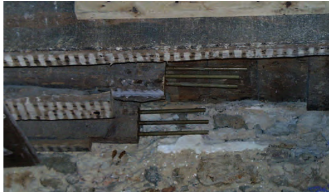
Varões fixados nas vigas (na madeira sã remanescente)
