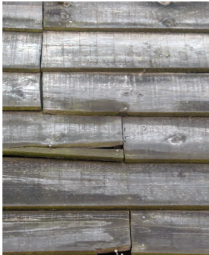
2 - Madeira alterada pelos raios ultravioleta
