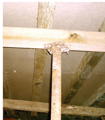
Escoramento do pavimento necessário devido ao acréscimo de esforços e deformação nos elementos de madeira antes do endurecimento de betão
