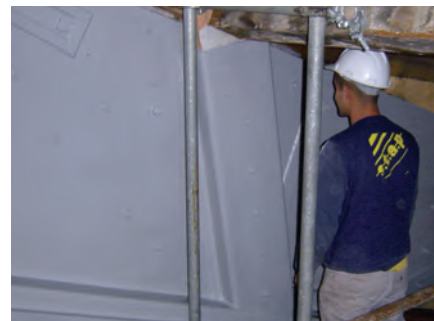
Aspecto final da reparação do nó
