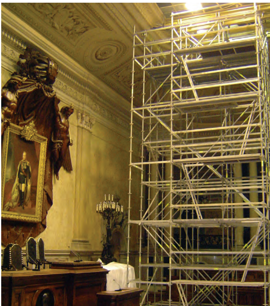
Escoramento do tecto da Sala do Senado
