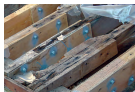
Exemplo de tratamento de apoio de vigas
