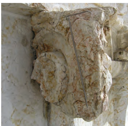
1 - Elemento em fase de reconstituição
