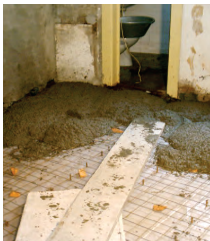
Intervenção utilizando ligação por cavilhas
