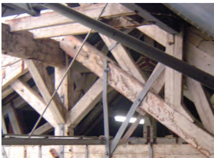
Vista parcial da estrutura da cobertura
