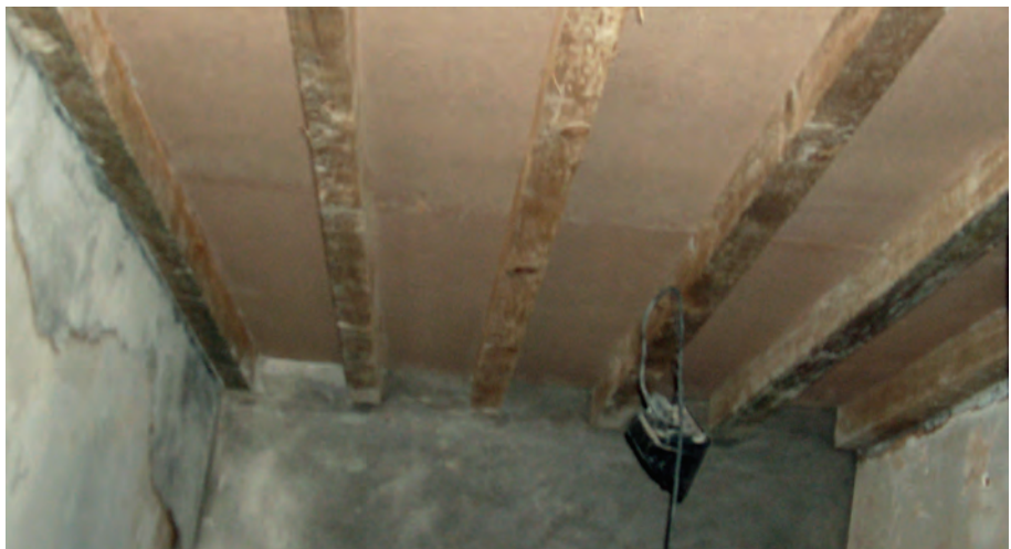
Vista da face inferior do pavimento após a intervenção
