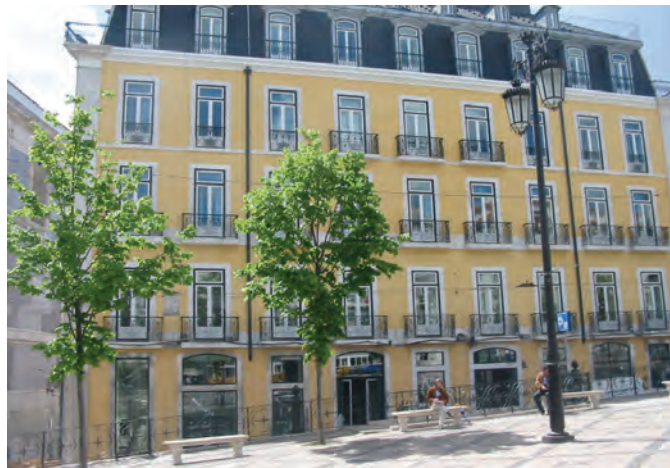
O edifício após a intervenção
