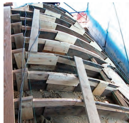
Fase de recuperação e reparação da estrutura
