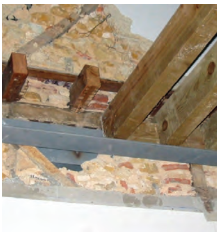
Novo pavimento do 5.º andar rebaixado e reforçado do existente
