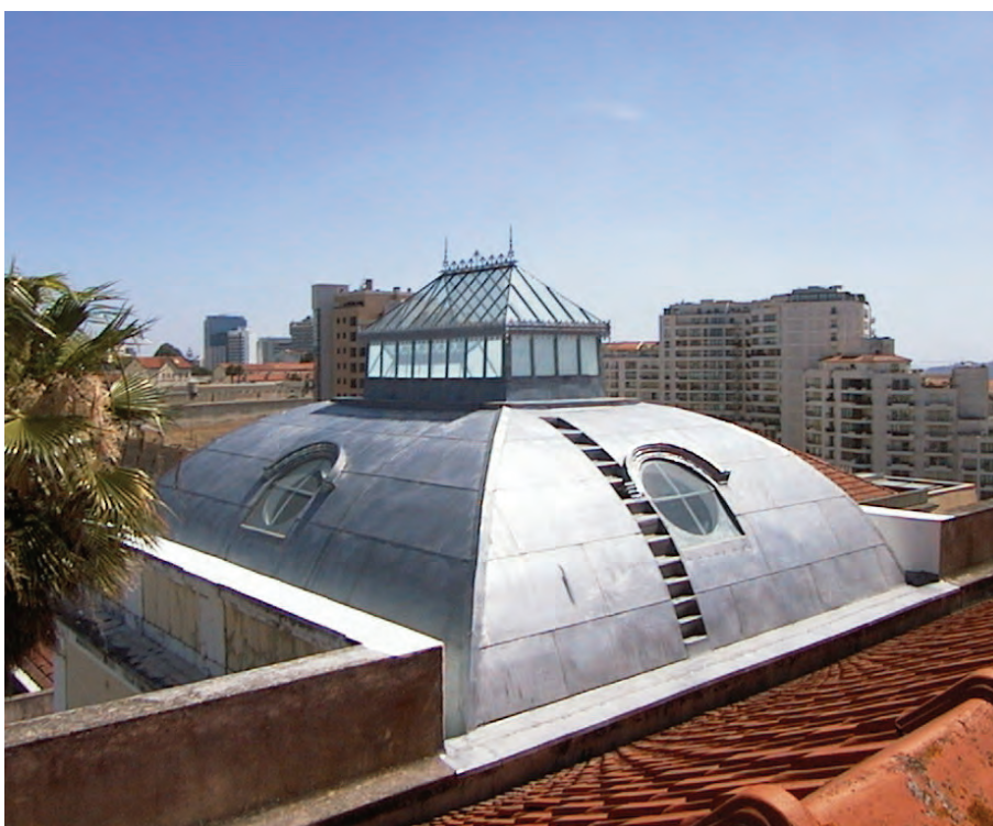
Vista geral da Cúpula concluída
