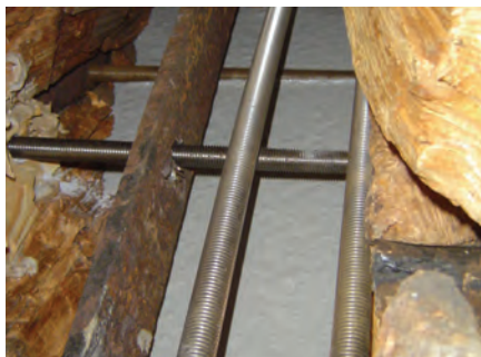
Reconstituição das secções com argamassa epoxídica
