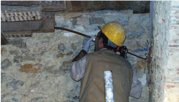
Injecção de cola epoxídica Timberset® Adhesive nos furos para instalação dos varões
