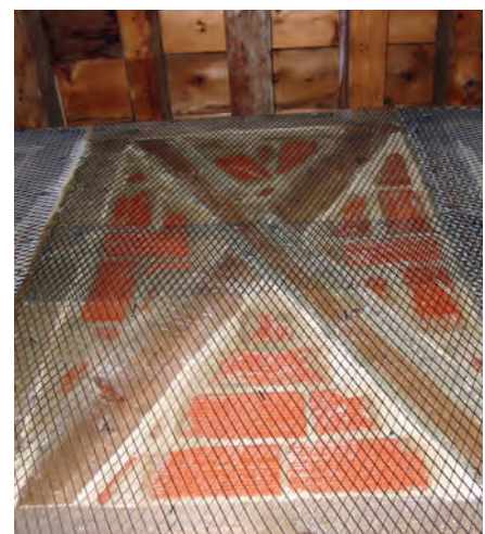
Frontal preenchido e reforçado com reboco armado
