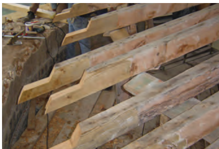
Tratamento de vigas por empalme
