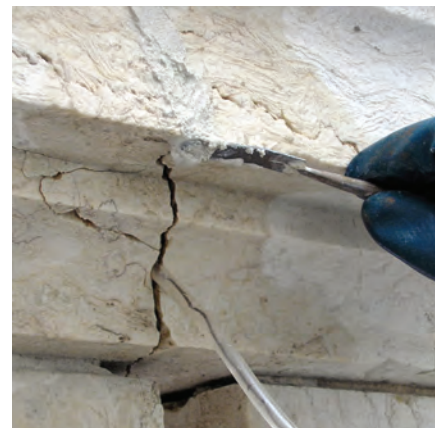
3 - Selagem para injeção de uma fractura
