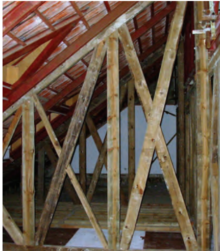
Novas paredes de frontal interligadas, sob a cobertura existente
