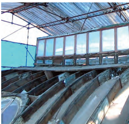
Estado da estrutura após remoção dos revestimentos
