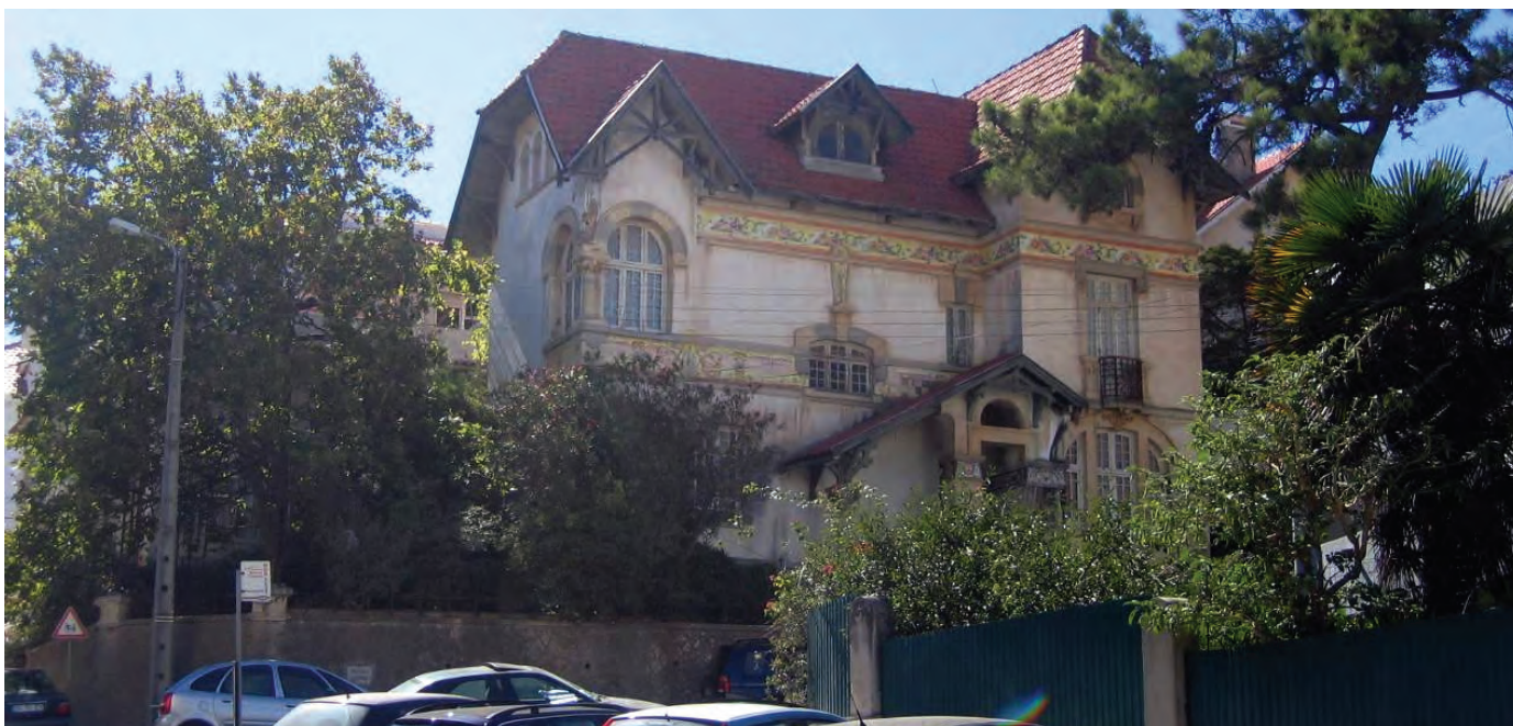
1 - Chalé Malvina. Av. Sanfré, n.º 1 - Monte Estoril. Vista geral de nascente
