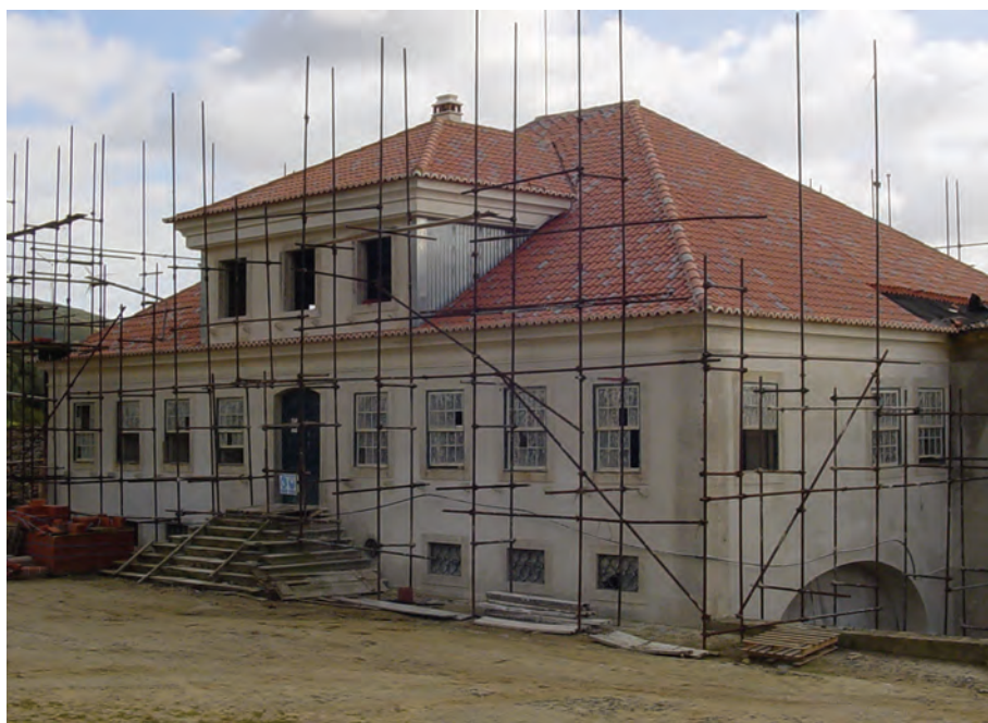
Edifício principal da Quinta do Calvel
