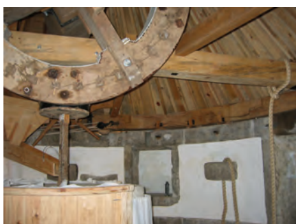
Interior do capelo. Tabuado de pinho
