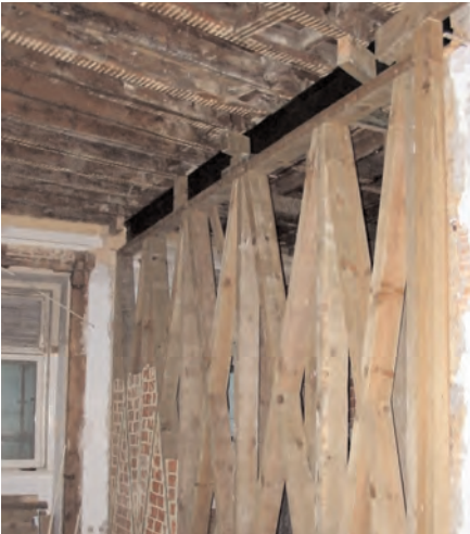
Nova parede frontal preenchida com alvenaria de tijolo
