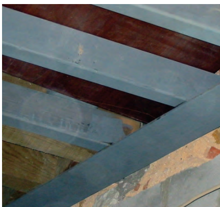
Recurso a vigamentos de aço, complementando o pavimento de madeira
