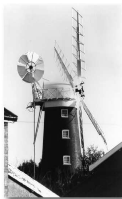
FIGURE 1.5 – Moulin à vent de Wicklewood, Norfolk, équipé d'un fantail - courtesy of Bennet B. Brabson [12]
