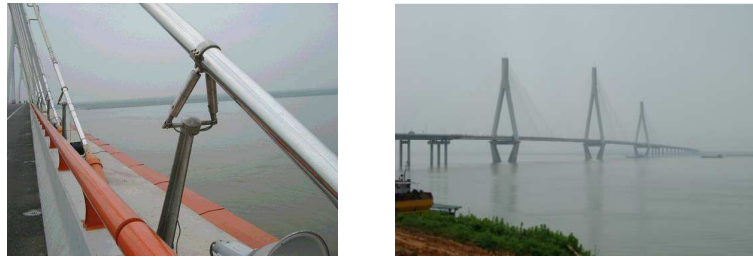
FIGURE 1.28 – Amortisseurs magnétorhéologiques, pont sur le lac de Dongting, Hunan, Chine, CIHPS, the Hong Kong Polytechnic
