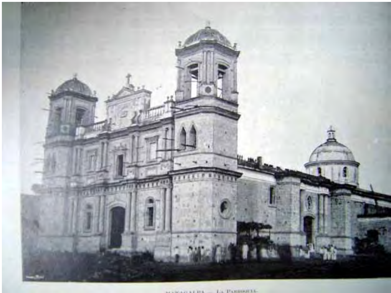
El templo de la Parroquia de Matagalpa San Pedro Apóstol, tres años después de su apertura al público. Obsérvese que todavía esta sin repello ni reloj y se ven los hoyos de los andamios. Foto tomada en 1898 por George Schmidt, alemán que luego administro el "Terrocarril" de Matagalpa
