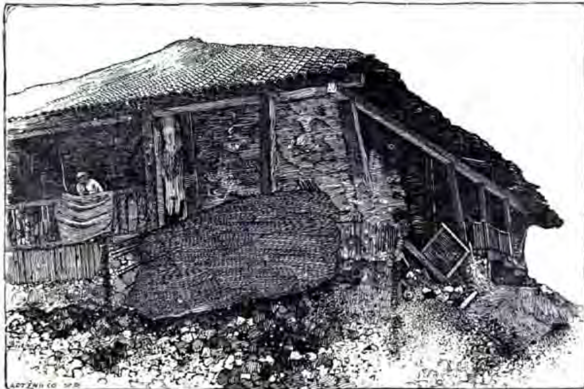
Hacienda Fuentes, after the earthquake.
