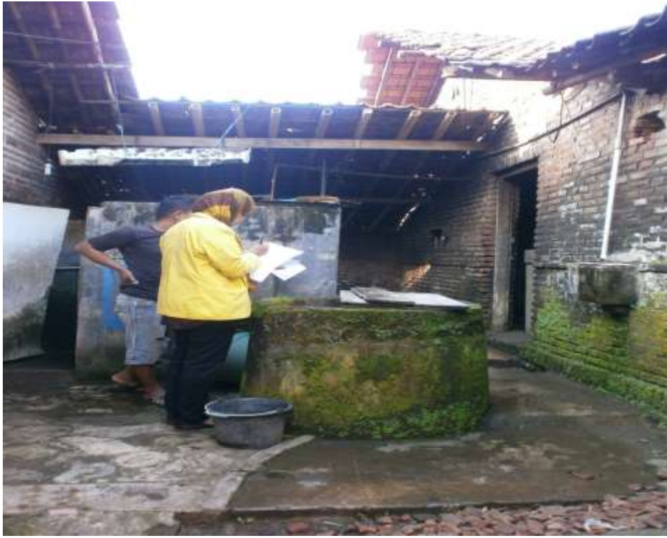
Gambar 7: Observasi Kondisi Sumur
