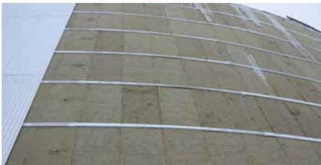
Los productos de la serie RHT de Roxul vienen en un rango de rígidos a semirrígidos, son lo suficientemente flexibles para ser instalados en tanques grandes de almacenamiento evitando la congelación de su contenido.
