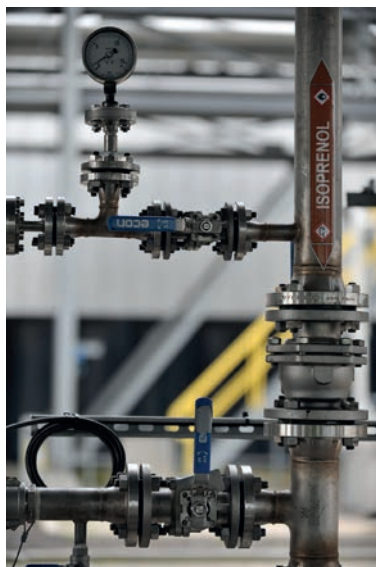
© Gilles Dacquin – Tuyau de transfert de produits chimiques
