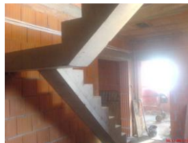
SCHODY ŁAMANE (schody zmieniające kierunek)
