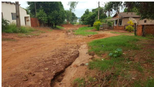
Foto 3.3 – Processo erosivo na Vila MD
