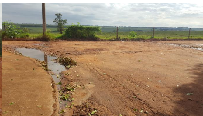
Foto 3.2 – Cruzamento das ruas Antonio Paladini com Rua Benigno Ferreira Gonda
