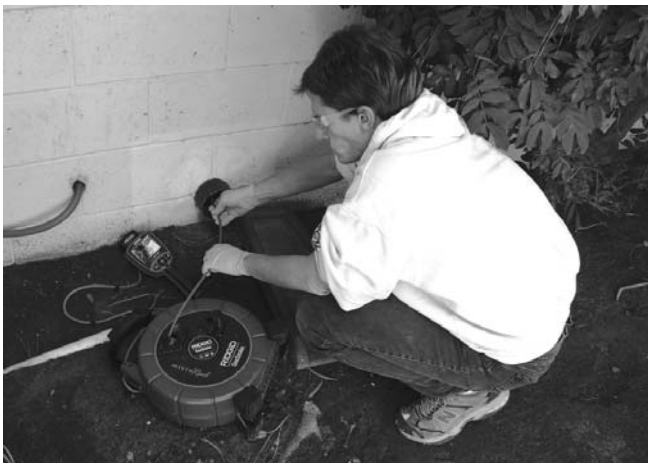
Figure 17 – Utilisation du microReel
