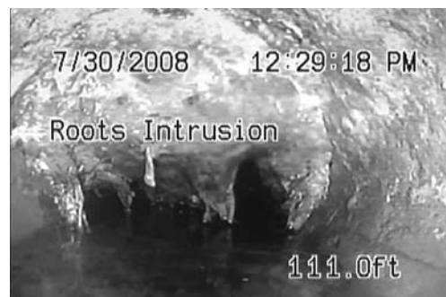
Figura 21 – Display en la pantalla muestra diapositiva superpuesta con texto, fecha, hora y distancia (medida desde el punto cero del sistema)
