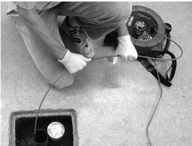
Figure 24 – Manière appropriée de rembobiner le câble d'avancement dans le tambour
