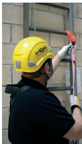
Anclaje de la línea de vida
