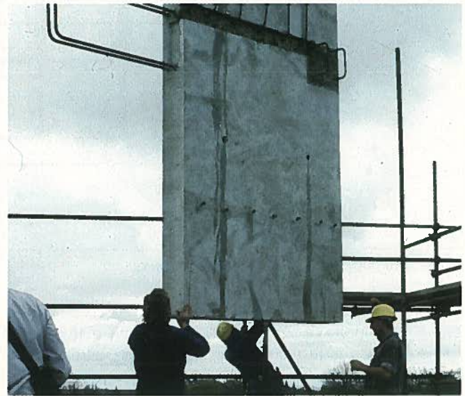
(d) Erection of panel
