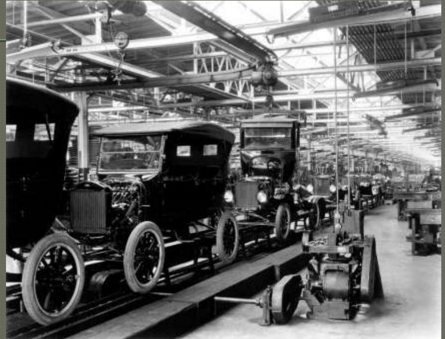
La catena di montaggio è un sistema di lavoro nel quale le diverse componenti delle parti di un prodotto da montare scorrono su binari davanti a operai che svolgono **un'unica mansione: il montaggio di quel pezzo entro un tempo calcolato come ideale**
