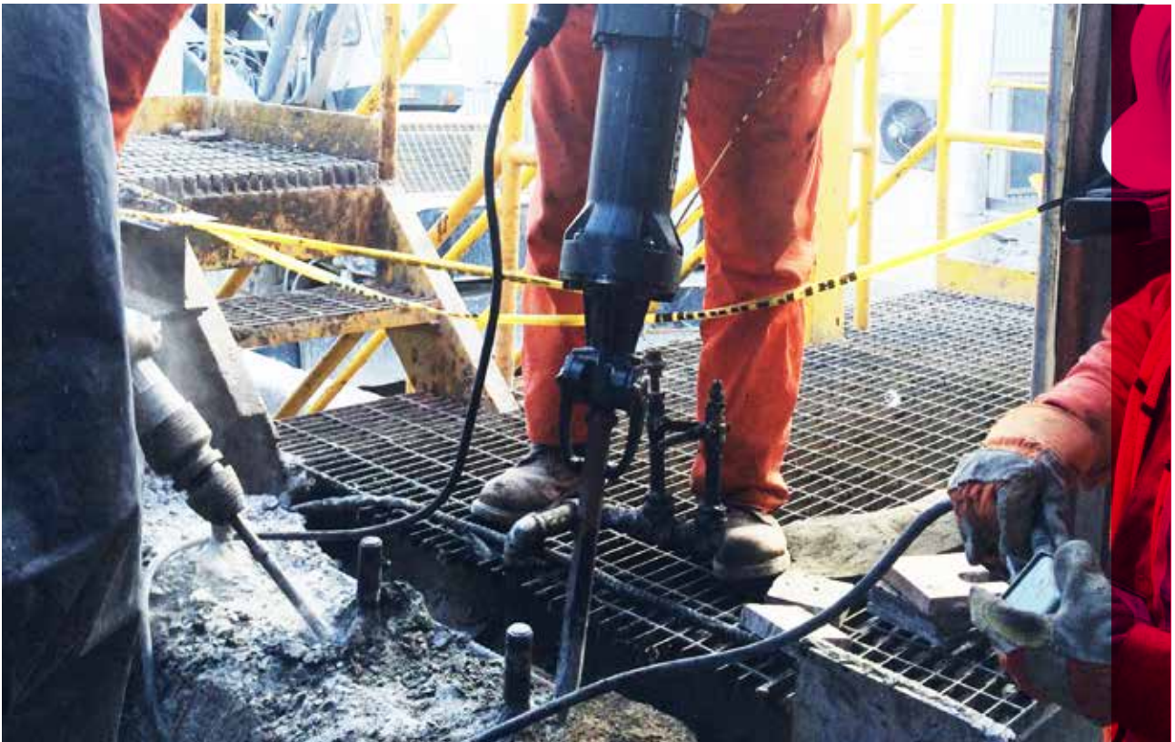
Picado de la cimentación.
