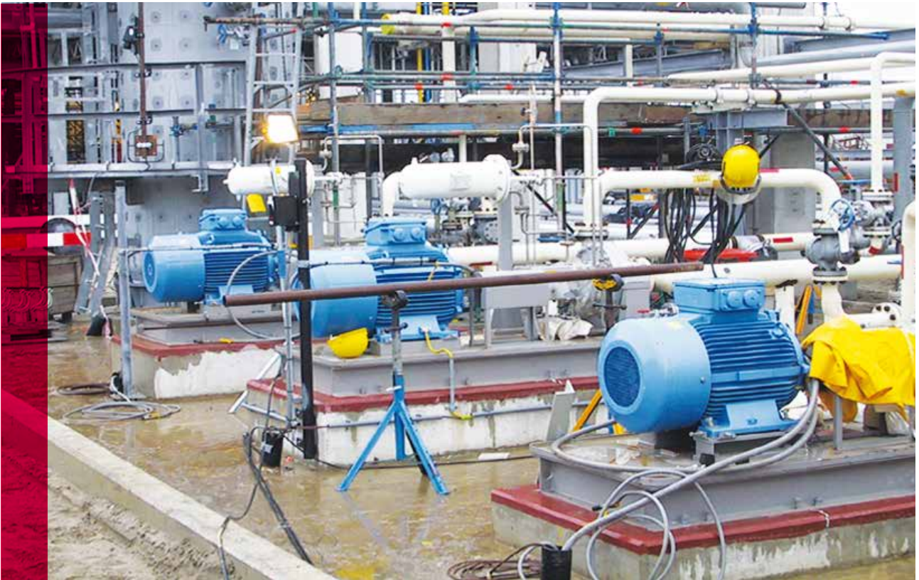
Grouting sobre bastidor de motor y bomba.
