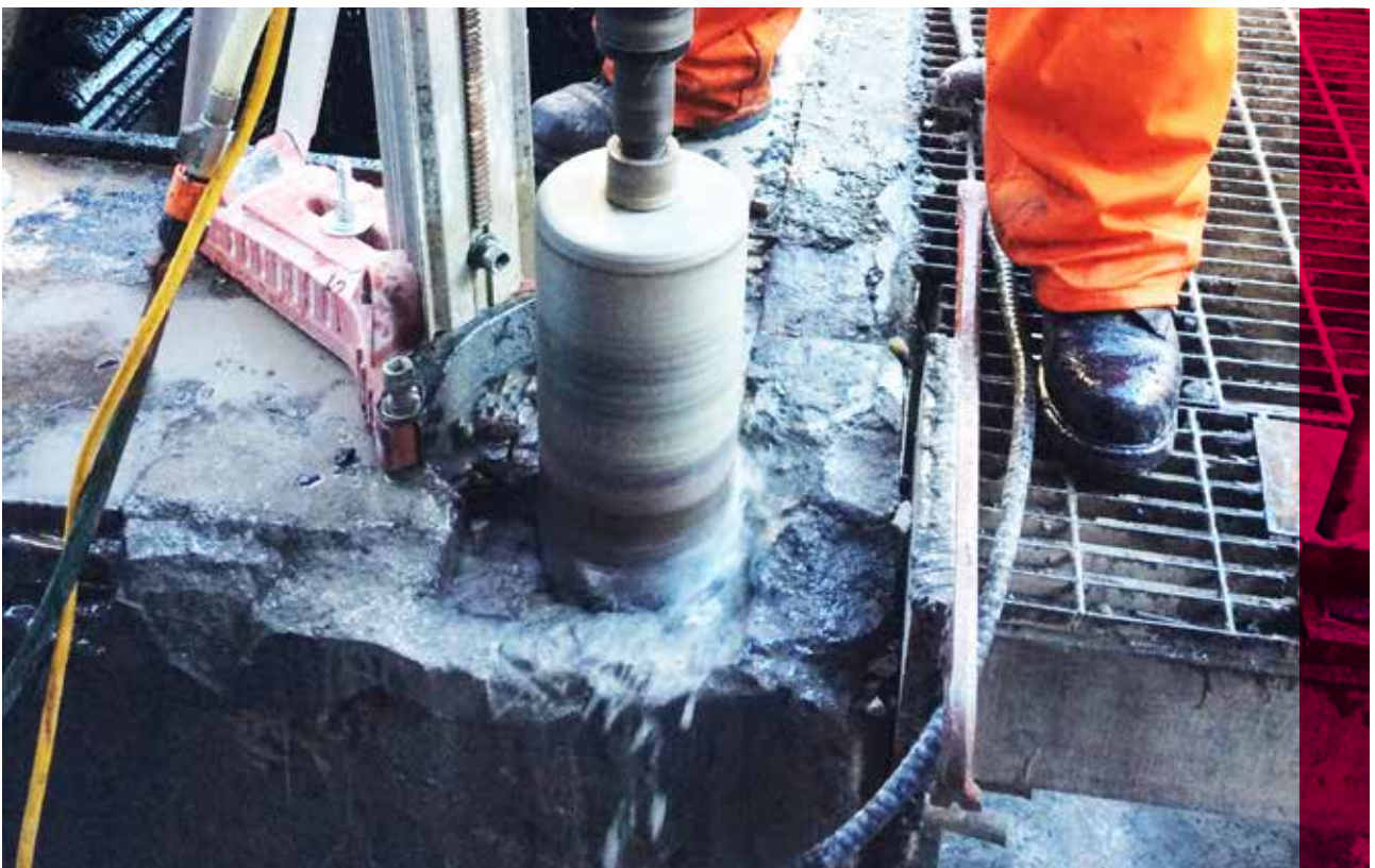
Barrenado para la extracción de pernos.
