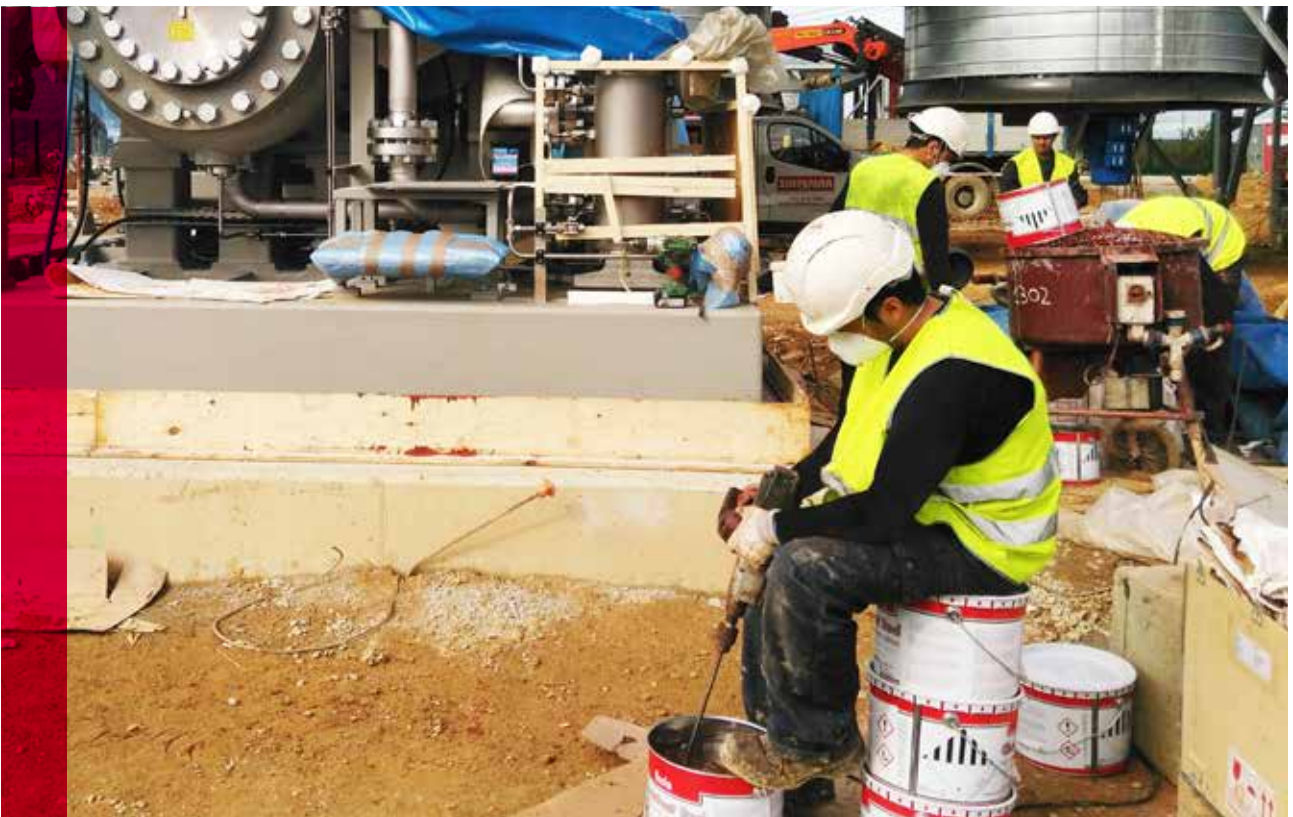
Mezclado de resina para grouting de compresor centrifugo.
