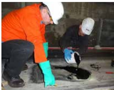
Reparación de bandas transportadoras con DEVCON R-Flex.
