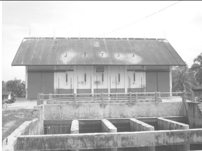
Rumah Pompa Intake Polder Alabio
