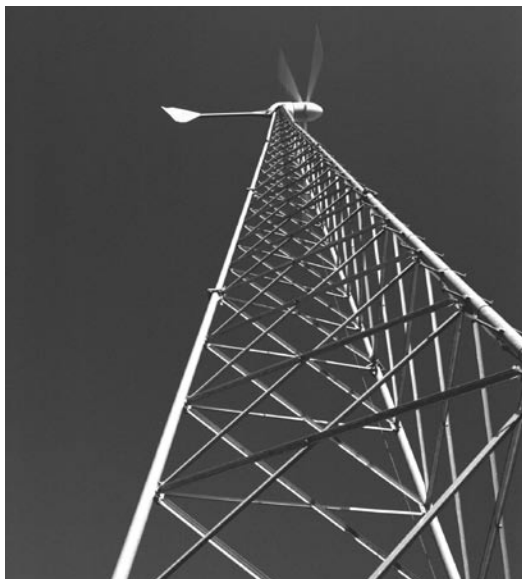
Warren Getz, NREL / PIX0615
