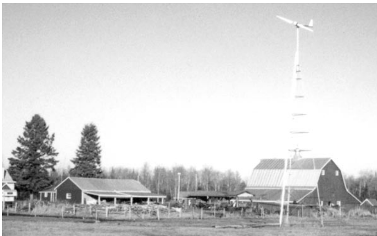
En Clover Valley, Minnesota, esta turbina eólica Whisper H175 de 3 kilowatts, se encuentra instalada en una torre de 50 pies, conectada a la red para compensar el suministro de energía de la red convencional.
