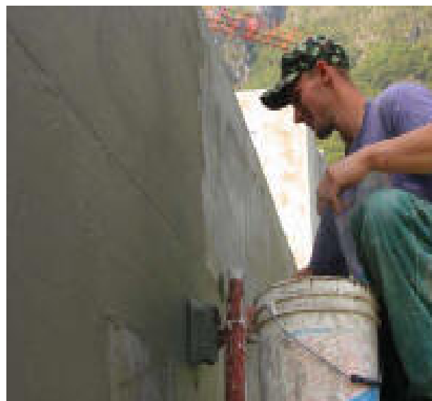
Aplicare masă hidroizolatoare PCI KANADICHT
