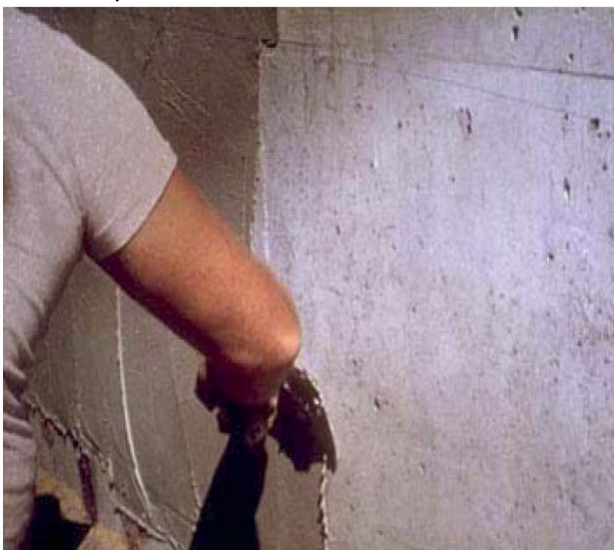
Aplicare masă hidroizolatoare flexibilă MASTERSEAL 588
