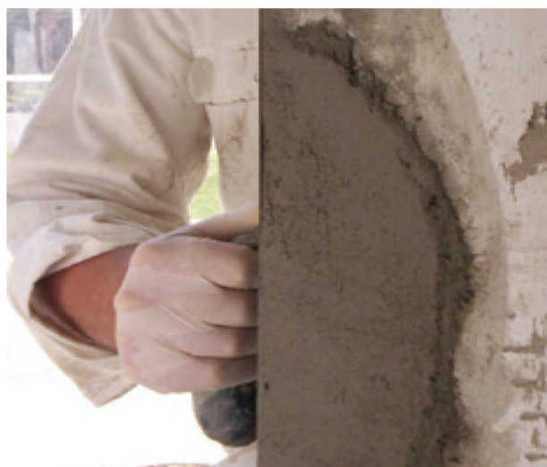
Reprofilarea structurilor din beton utilizându-se mortarele din gama EMACO și EMACO NANOCRETE
