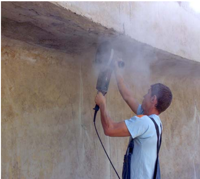
Deschiderea și tratarea fisurilor
