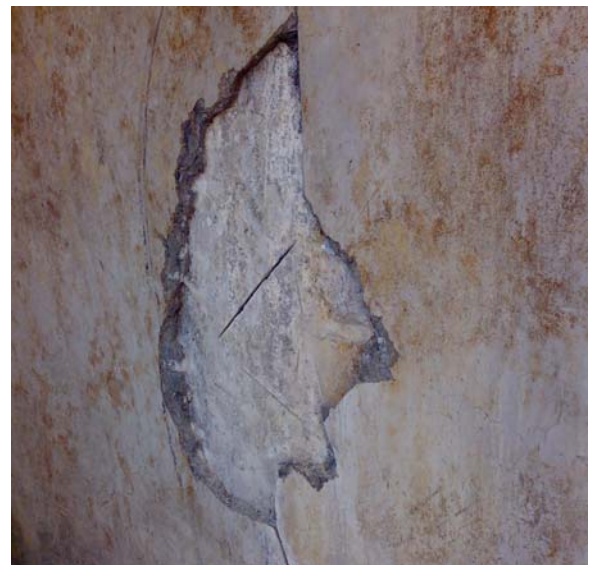
Îndepărtarea stratului de material contaminat sau îmbătrânit
