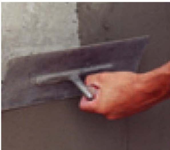
Refacerea stratului suport utilizându-se mortarele din gama EMACO și EMACO NANOCRETE
