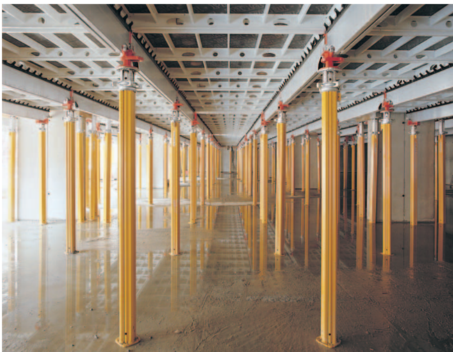
La grande distance entre étais - 1,50 x 2,30 m - signifie gain de temps et liberté de mouvement pour le transport de matériel.
