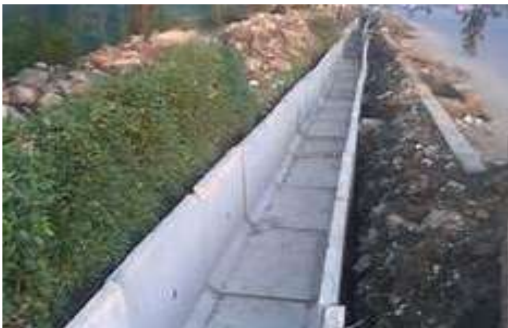
GAMBAR 4 SALURAN TERBUKA PRACETAK
