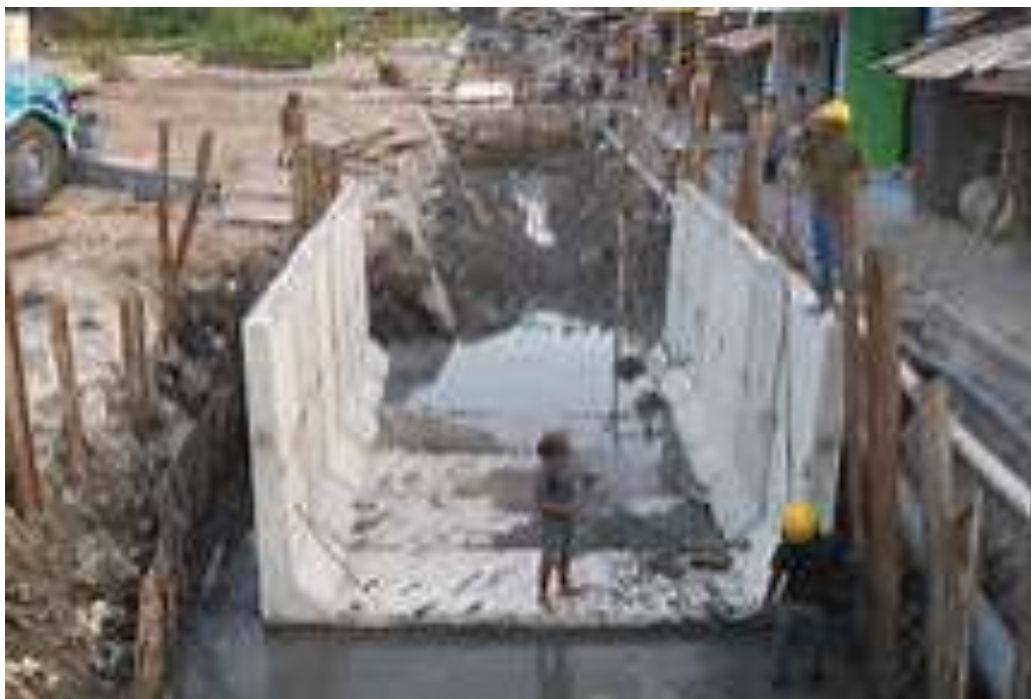
GAMBAR 3 BENTUK SALURAN SAMPING PRACETAK
