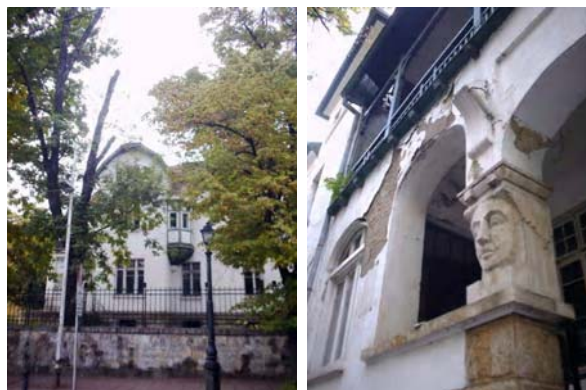
Фотос 16. Къщата на арх. Г. Фингов на ул. „Шипка” 38 – откъм ул. „В. Априлов” (горе) и откъм ул. „Шипка” (вляво). Каменната глава на входа с лице към ул. „Шипка” (вдясно) е дело на скулптора Андрей Николов.
