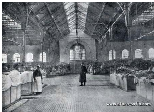
Фотос 10. Вътрешната метална конструкция в интериора на Софийските централни хали, 1911.
