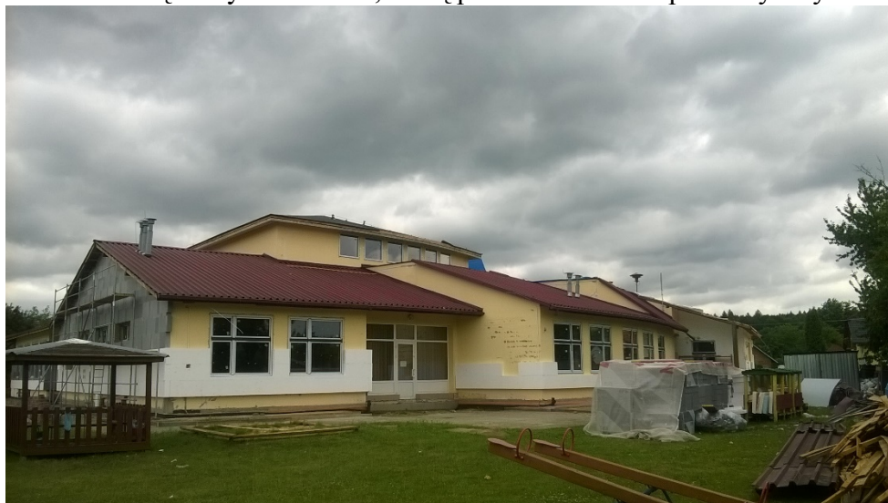
Rys. 1. Połąć przeznaczona pod montaż.
