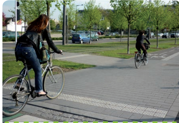
Les abaissements de trottoir profitent aussi aux cyclistes
