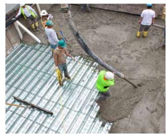
**Versa-Floor**™ LONG-SPAN COMPOSITE SYSTEMS
