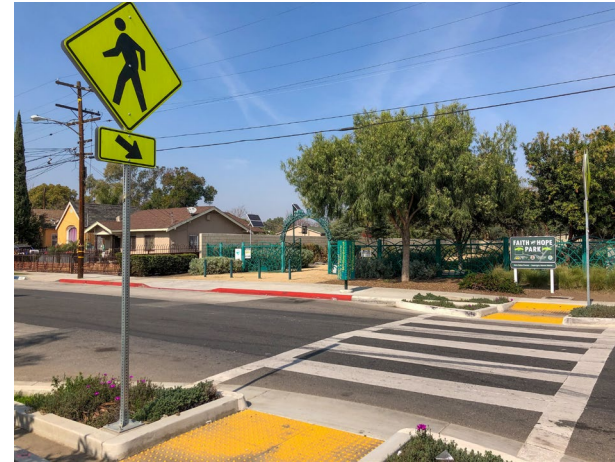
Continental crosswalk / Cruce no semaforizado
