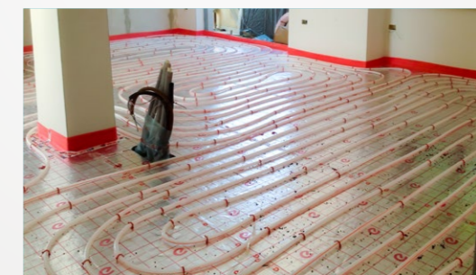
Impianto Radiante a Pavimento Ristrutturazione 130 mq
