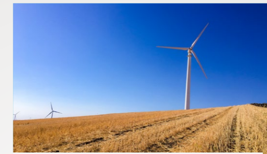
Impianto Eolico da 60 kWe
