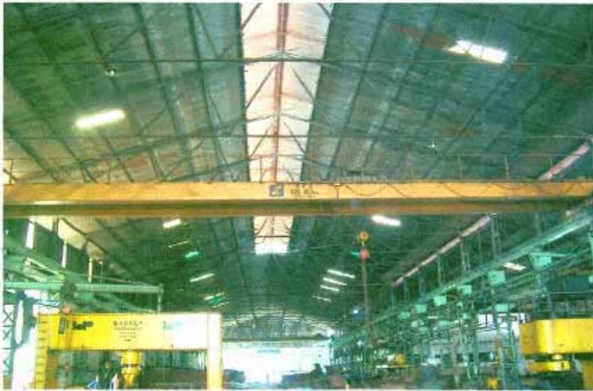
Gambar XI.18 Motor Area pada Crane Jembatan 10 Ton
