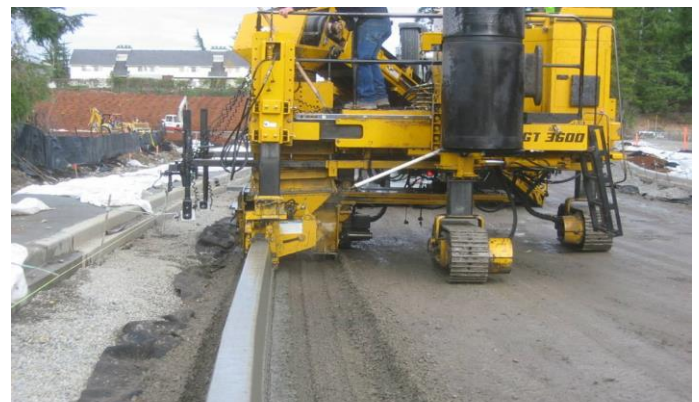
Figure 10: Pour Inside Curb
