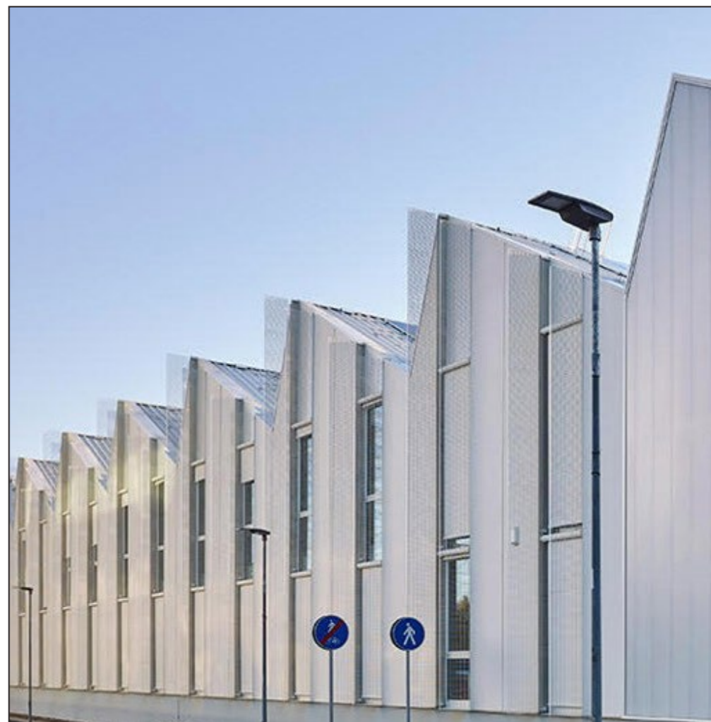
progetto: Diverserighestudio servizi: verifica del fattore di luce diurna medio e del comfort visivo
