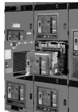
Interruptor NW removido en PZ4
