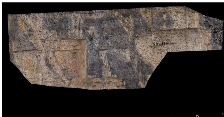
Fig. 5. Sector analizado del desprendimiento del talud. El sector se encuentra a la derecha del desprendimiento en la zona central del mismo.
