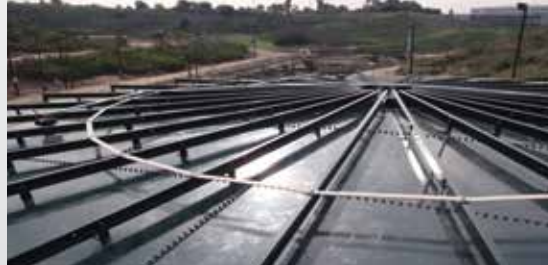
Contamos con vigas externas de techo!
