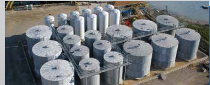
Galveston, TX – (6) tanques de 125K y (7) tanques de 48K galones
