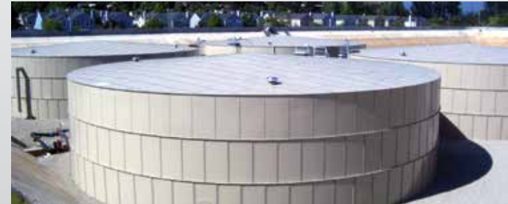
Santa Cruz, CA - (4) tanques de 1.5 millones de galones
