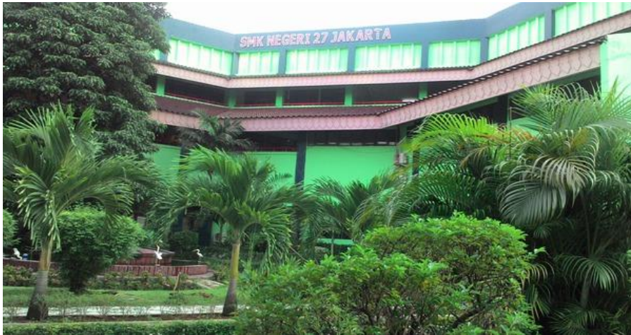
Gambar 58. Gedung SMK Negeri 27, Jakarta
