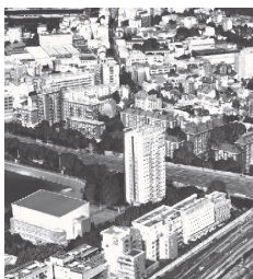
Tour Poissonniers, bâtiment de Raymond Lopez (1958)
