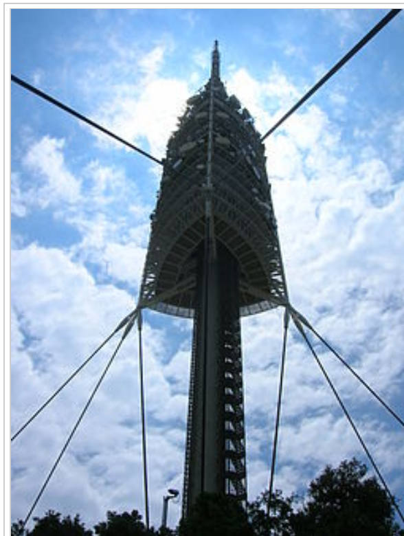
Torre de telecomunicaciones de Collserola, (Barcelona).
