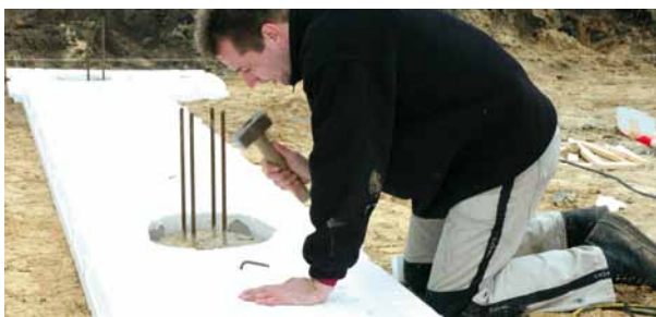
3 Met bodemplaten verbindingen maken tussen de hoeken.
