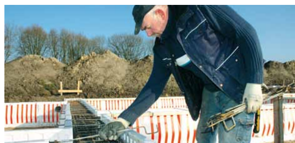
6 Bovenbeugels aanbrengen, ca. 600 mm h.o.h.
