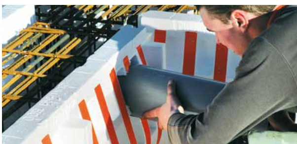
5 Eventuele sparingen maken en zijwanden plaatsen.
