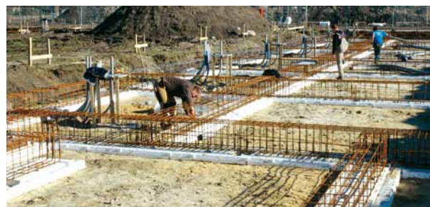
4 Wapening plaatsen en afstandhouders aanbrengen die voldoende betondekking geven en geschikt zijn voor isolatie op zachte ondergrond.
