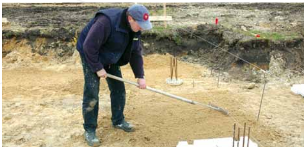
1 Het zandbed zodanig egaliseren en verdichten dat de bodemplaten voldoende ondersteuning krijgen.
