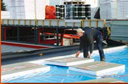
plat dak isolatie
