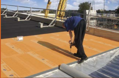
plat dak isolatie
