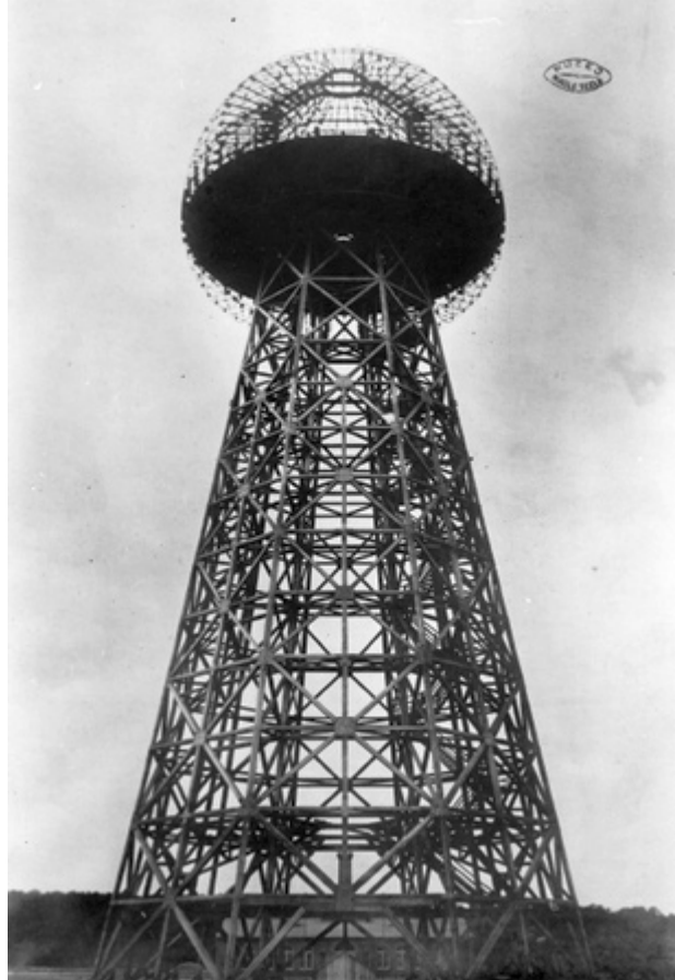
Imagen 14.7. La torre en Wardenclyffe con el terminal hemisférico en la cima. De DKS, Instituto Smithsonian.
