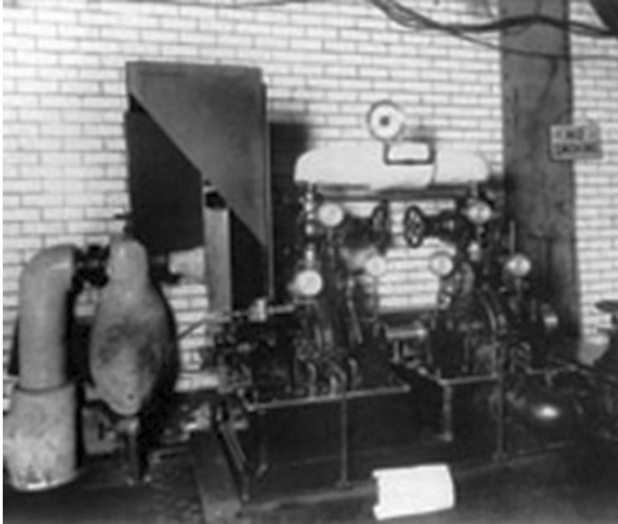
Imagen 16.2. Aparato de prueba de la turbina de Tesla en Edison Waterside Station, Nueva York en 1912. Obsérvese el resorte de torsión coloreado que conecta las dos máquinas. De Frank Parker Stockbridge, «The Tesla Turbine», World's Work , 23 (1911-1912): 543-548.
