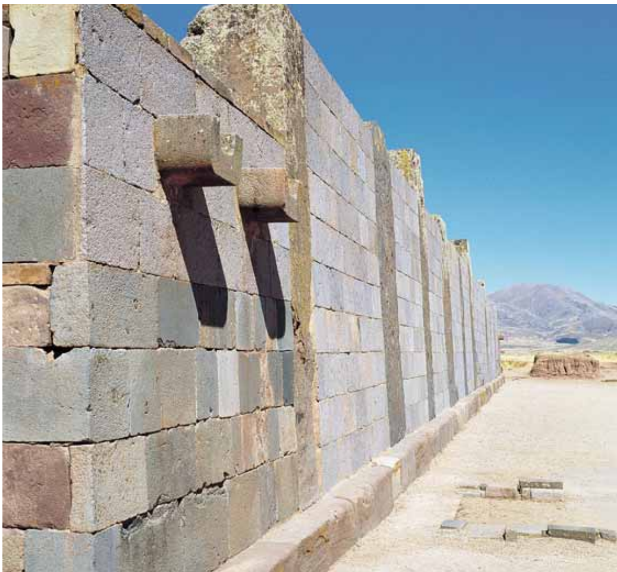
Sillares, pilares y gárgolas en el muro oeste del Kalasasaya.
