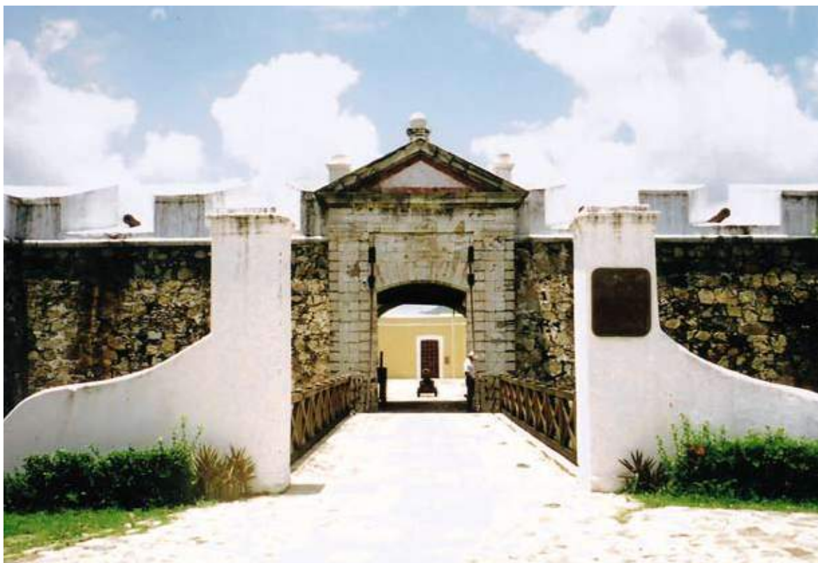
Estado actual de la fachada del Fuerte de San Diego, Acapulco, Gro.
