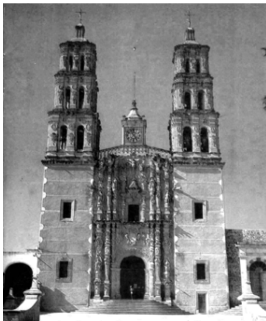
Fachada principal de la iglesia de Dolores, donde inició el movimiento emancipador.
