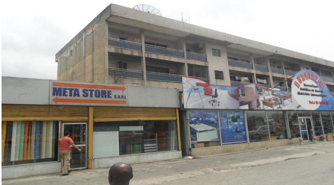
Photo 10: Immeuble habité à proximité du site du projet
