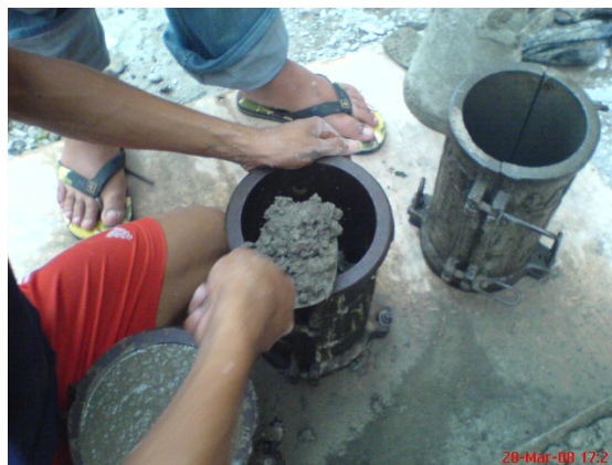
Penuangan adukan kedalam Bekisting
