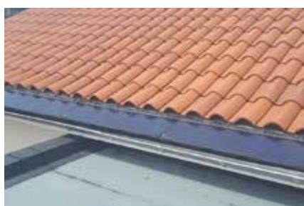
Pose à l'égout
