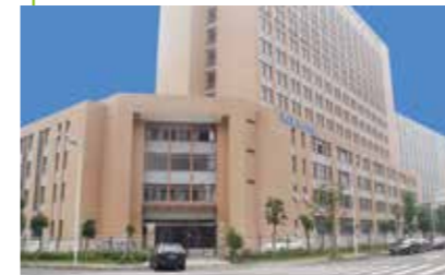
寧波アルバック・クライオ有限公司 ULVAC CRYOGENICS (NINGBO) INCORPORATED
