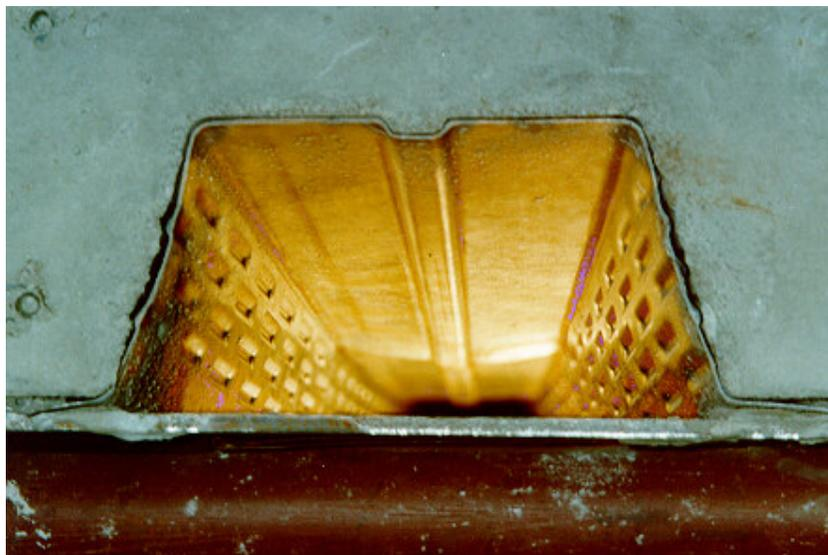
Figura C.4 – Flambagem local da fôrma de aço
