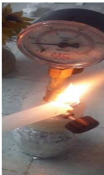
Figura 15-Queima do biogás para redução da pressão interna no reator.
