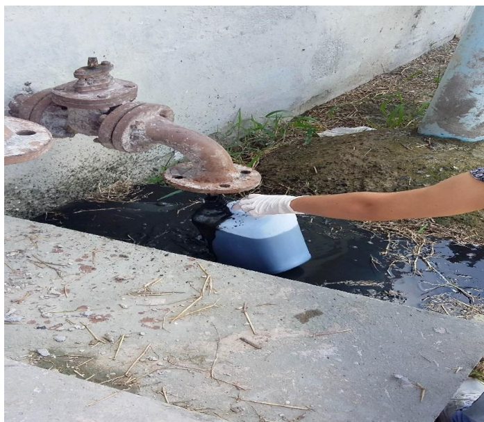
Figura 12-Coleta de lodo anaeróbio em reator UASB, Estação de Tratamento de Esgoto da Mangueira, Recife, Pernambuco.
