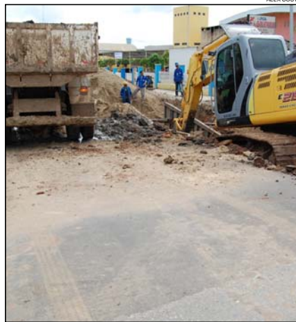
Obra se estende até próximo a avenida Leste-Oeste
