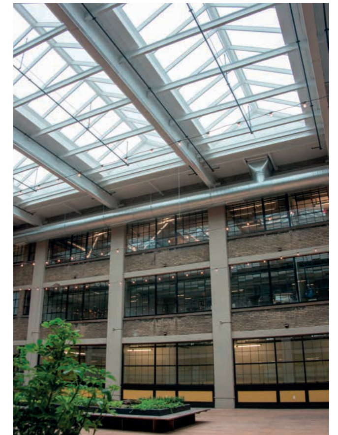
500 Seneca St, Buffalo, USA. 128 modules.
