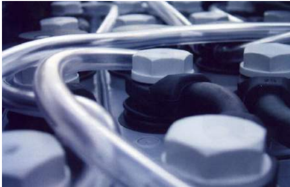
Figuur 66: Cellen in serie/automatisch vulsysteem
